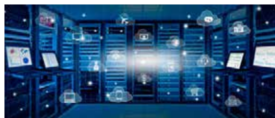
Fig.2 Salle de centre de données internet avec serveur ©Yanawut Suntornkij - stock.adobe.com
